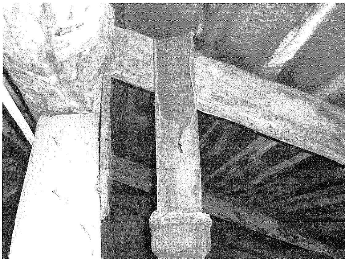
Канализационный стояк не выведен на кровлю, не утеплен
